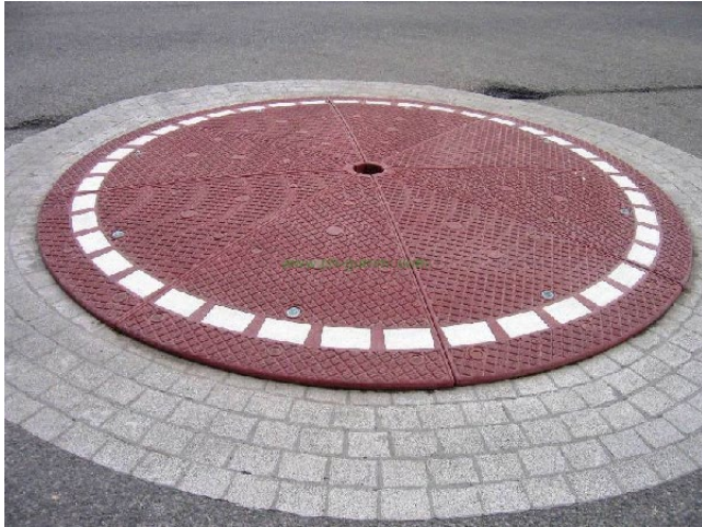
Diameter på 3 meter + evt. skilt eller pullert.
