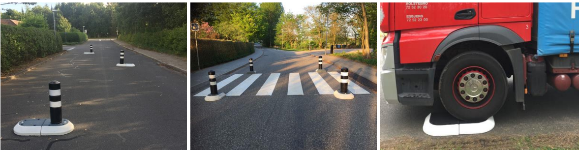
Indsnævring med gummihelleanlæg.
