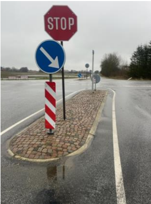
Nedsunken helleanlæg på grund af flere slidlag
