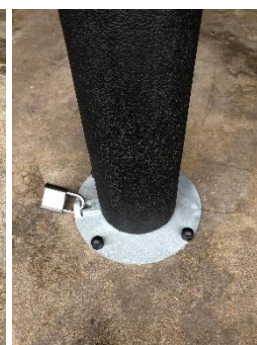
Aftageligt beslag med lås. Frihøjde 2,5cm.
