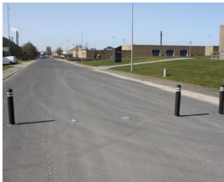
Aftageligt beslag. Åbning til gennemkørsel.
